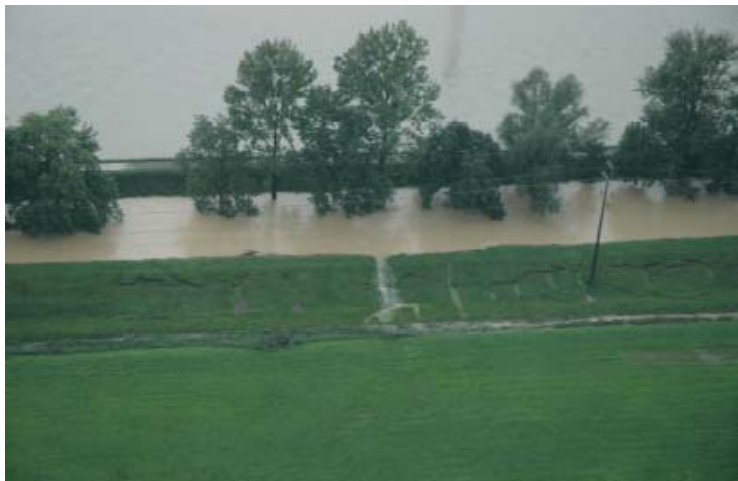
Abb. 5: Rechter Hintergraben, Hochwasserereignis August 2005: Ein Dambruch hätte mit grosser Wahrscheinlichkeit auch den Bruch des Hauptdammes zur Folge. Fig. 5: The right backside trench during the flood in August, 2005. A dam break would have most likely caused the break of the main levee as well.
