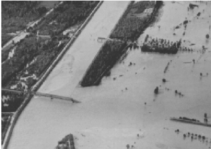
Abb. 12: Beispiel eines Dambruches am Alpenrhein beim Hochwasser 1927. Weil der Damm brach, floss praktisch der ganze Alpenrhein aus.
