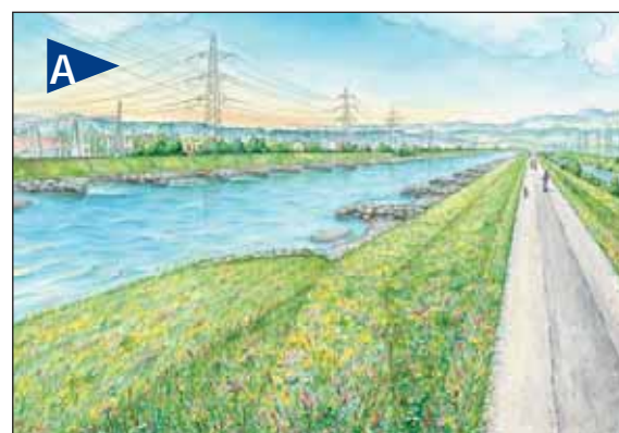
Linthkanal zwischen Giessen und Grynau (ganz rechts: Hintergraben und Damm zum F-Kanal)
