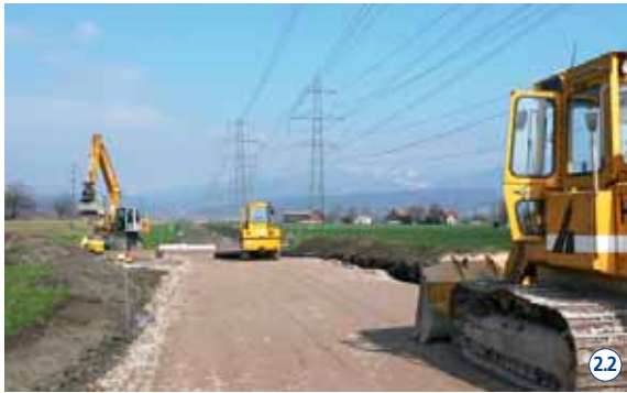
Bau der Nebengrabenstrasse zwischen Giessen und Grynau. 2.2
