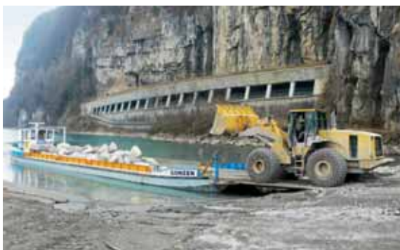
Anlieferung von Steinblöcken für die Verbauungen über den Walensee. 5.2
