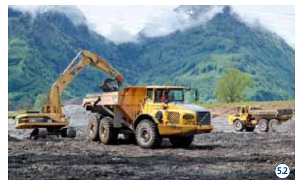
Chli Gäsitschachen: Hinter dem Damm wird die Flussaufweitung vorbereitet.
