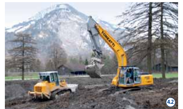
Im Gäsi wird der Damm erhöht und verlängert.
