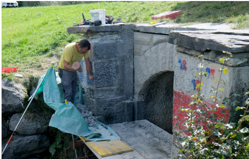
Sanierung des Durchlasses Hilterngraben
