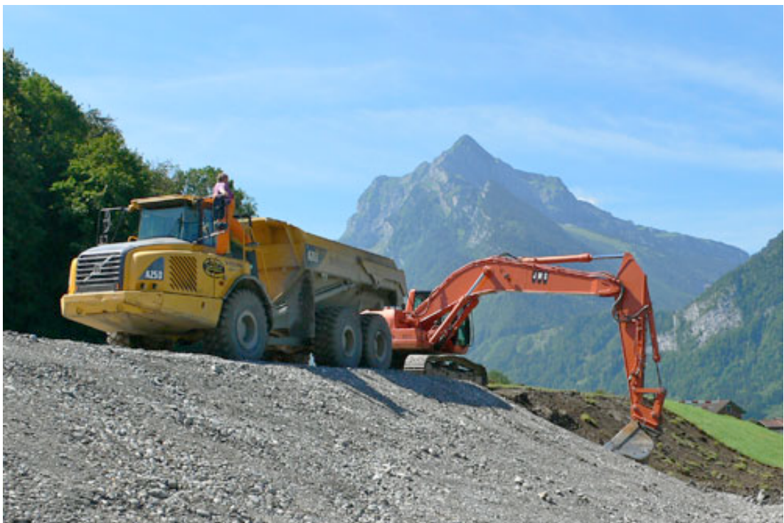
Escherkanal: Dammsanierungsarbeiten am Chupfernrank (Herbst 2009).
