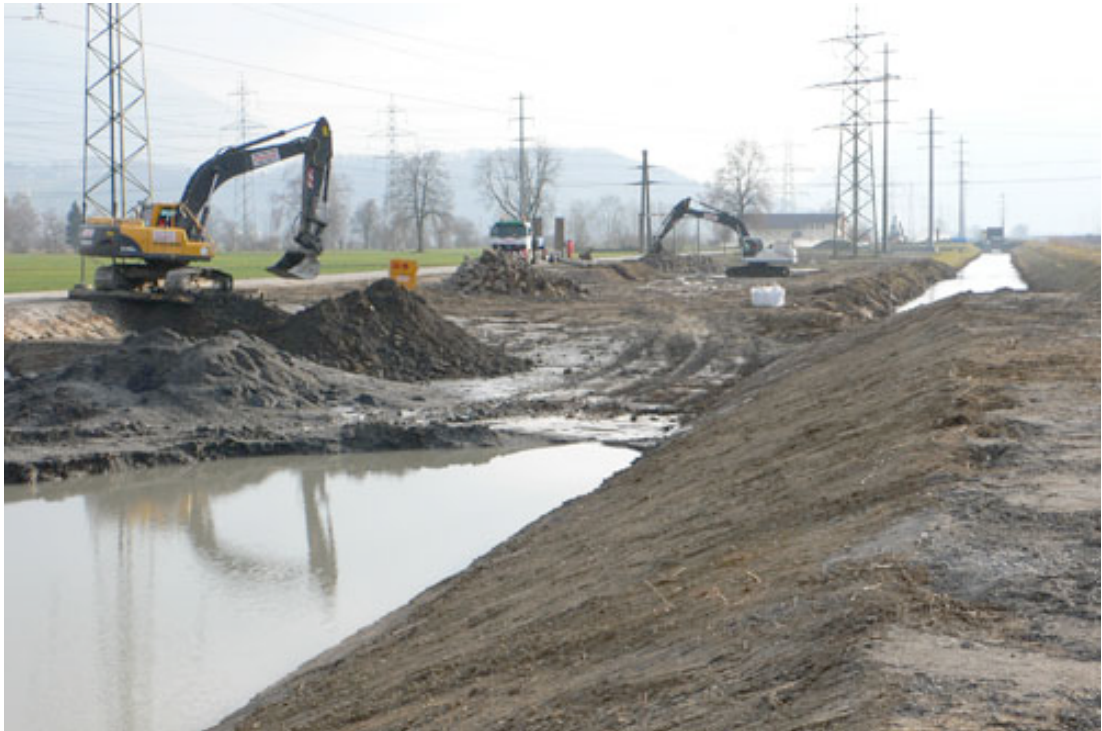
Linthkanal: Verlegung der Gräben in der Gryнау (Dezember 2009).
