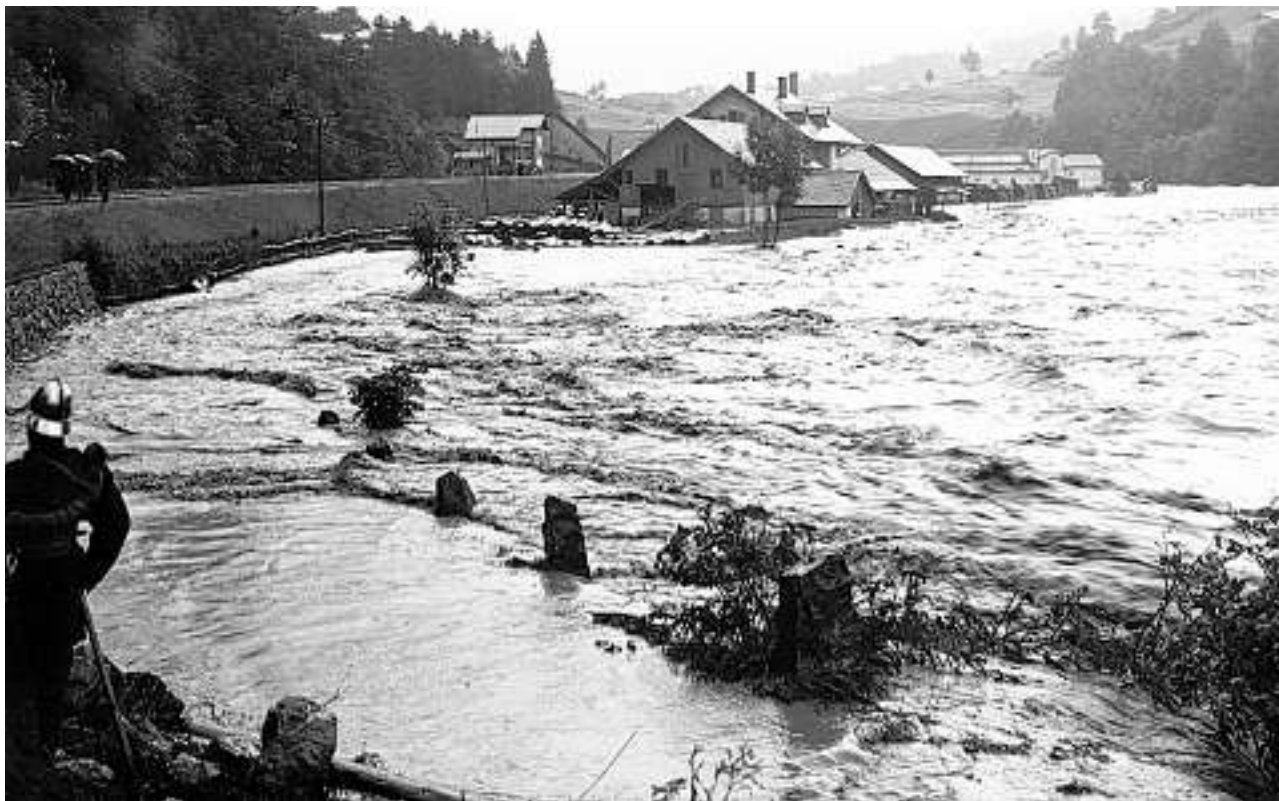
Land unter: Im Ennendaner Mühlefuhr überschwemmt die Linth 1910 Sägerei, Strasse und Fabrik. Bilder Glarner Landesarchiv
