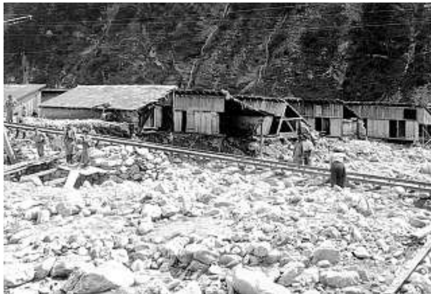
Engi: Der Mühlebach zerstört Strasse, Bahngleise und Ziegenställe.
