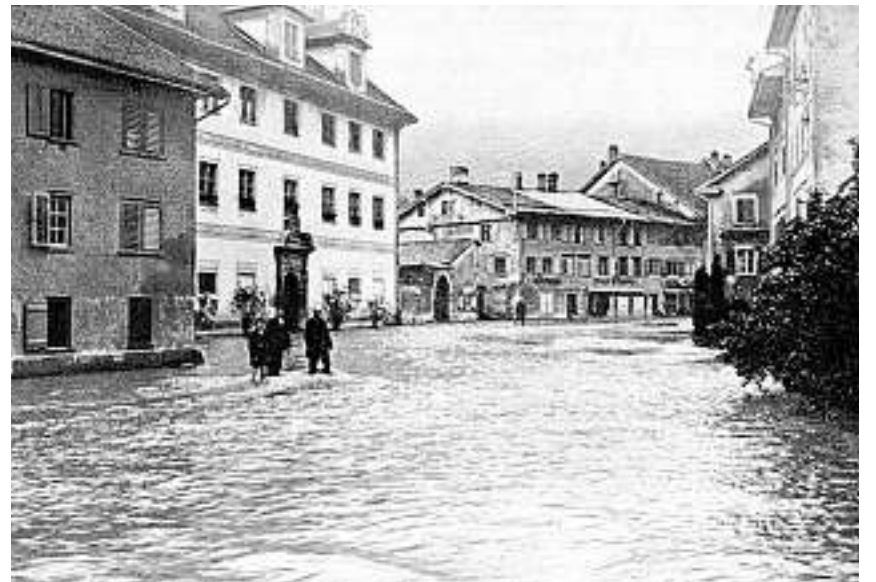
Näfels: Das Dorfzentrum wird von den Bächen überflutet.
