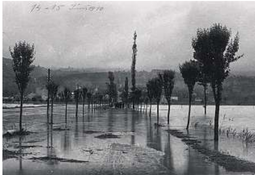
Sintflut: Mitte Juni 1910 überflutet ein Hochwasser die Grynaustrasse in Uznach.
