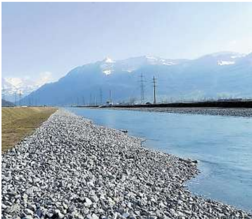
Das neue Ufer (links) ist untergründig von einem nicht sichtbaren Längsverbau gestärkt. Damit schaut die Linth natürlicher aus als früher (rechts). Bilder: zvg
