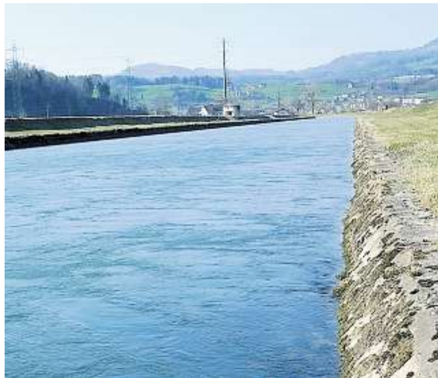
Das neue Ufer (links) ist untergründig von einem nicht sichtbaren Längsverbau gestärkt. Damit schaut die Linth natürlicher aus als früher (rechts). Bilder: zvg
