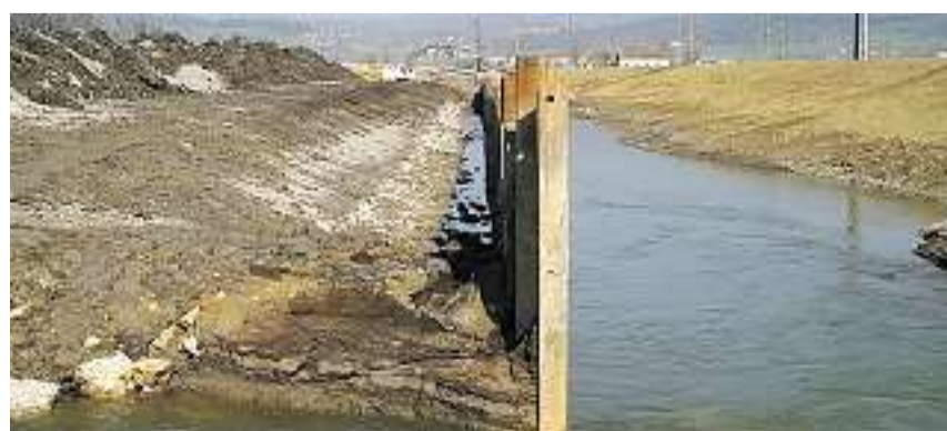
Auch der Hintergraben wird etappenweise neu angelegt und das Wasser umgeleitet, damit die Dämme verbreitert werden können. Bild: Sarah Gaffuri
