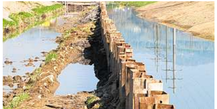
Verschiebung: Der Hintergraben (im Bild links der Spundwände) wird nördlicher gezogen (neuer Verlauf im Bild rechts).
