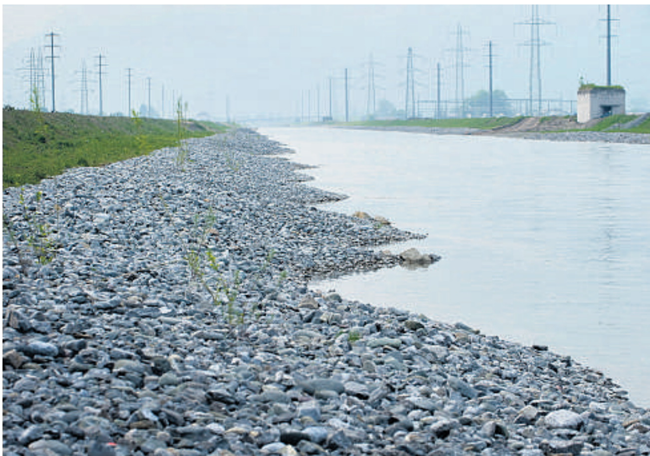
Der Linthkanal wird abschnittsweise umgestaltet – so entstehen unter anderem neue Flachufer.
