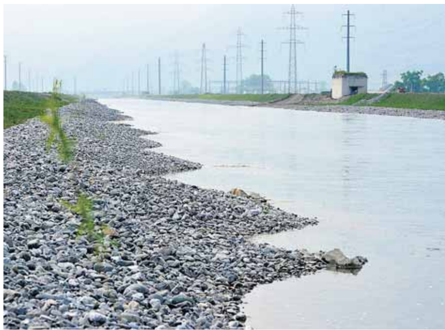
Neues Flachufer am Linthkanal, gestärkt von einer nicht sichtbaren Längsverbauung.
