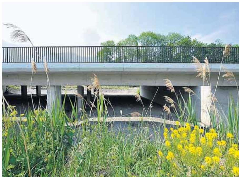
Die Wildtiere nutzen den Durchlass unter der A3 bereits.
