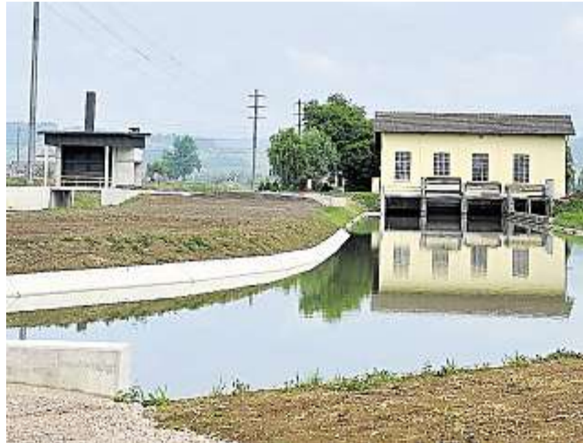
Ein neuer Schieber beim Pumpwerk Uznach und ein breiterer Graben ermöglichen das Regulieren des abfliessenden Wassers. Bilder: Manuela Matt
