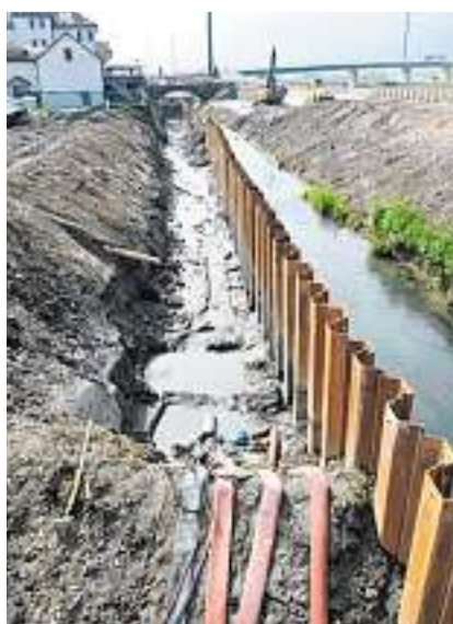
Verstärkung: Beim «Sternen» wird der alte Damm verstärkt.
