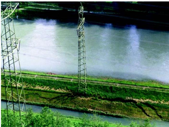
**Abb. 8:** Grundbrucherscheinungen mit Böschungsfussrutschungen am Linthkanal, Hochwasser 1999: Szenario für obige Überflutungsmodellierung.
