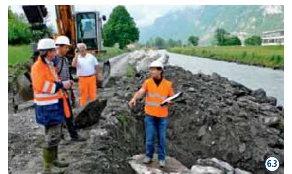
Anpassung des Vorlands für mehr Abfluss zwischen Näfels und Mollis.
