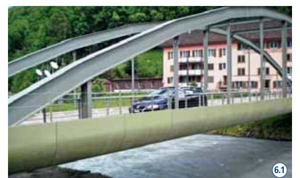
Am Linthbrüggli wurde eine Schürze gegen Verklauungen angebracht.
