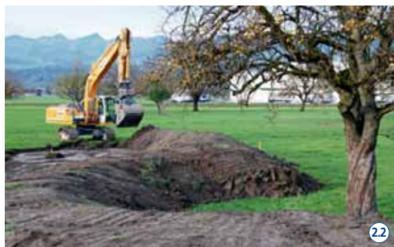
Die Bauarbeiten am Linthkanal beginnen zuerst in der Ebene. 2.2
