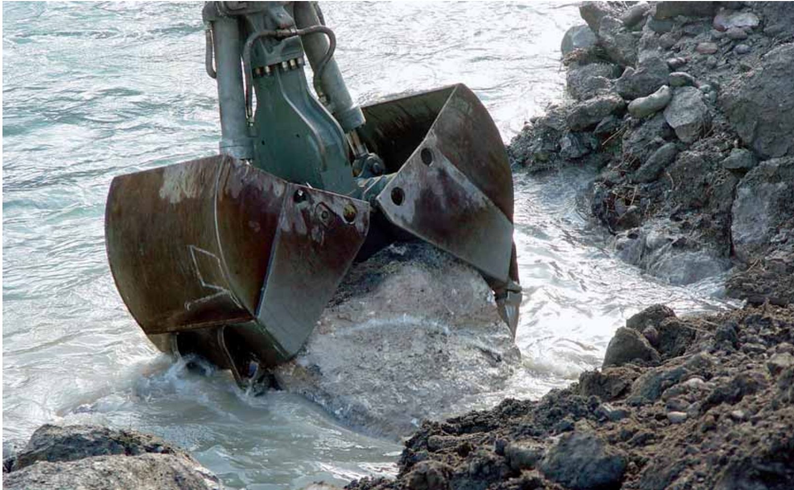
Arbeiten im Wasser – hier am Escherkanal – verlangt viel Können: Jeder Steinblock muss exakt am richtigen Ort positioniert werden.
