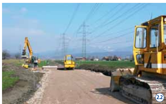
Bau der Nebengrabenstrasse zwischen Giessen und Grynau. 2.2
